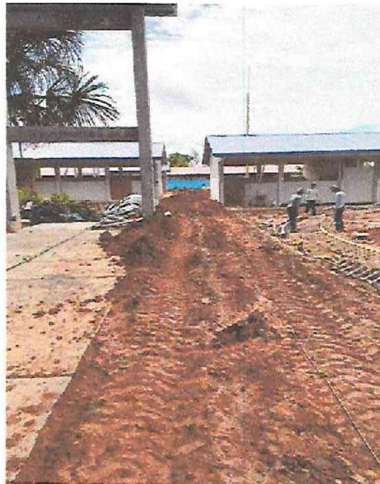
FOTO N°14: Vista del relleno de zanja de tubería para desagüe en la obra "Mejoramiento y Equipamiento del servicio Educativo N° 62200 Barrio Carabanchel - San Lorenzo, Distrito Barranca, Provincia Datem Del Marañón - Loreto".
