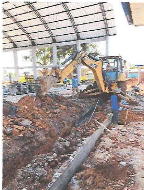
FOTO N°08: Vista excavación de zanjas con maquinaria al frontis de polideportivo en la obra "Mejoramiento y Equipamiento del servicio Educativo N° 62200 Barrio Carabanchel - San Lorenzo, Distrito Barranca, Provincia Datem Del Marañón - Loreto".
