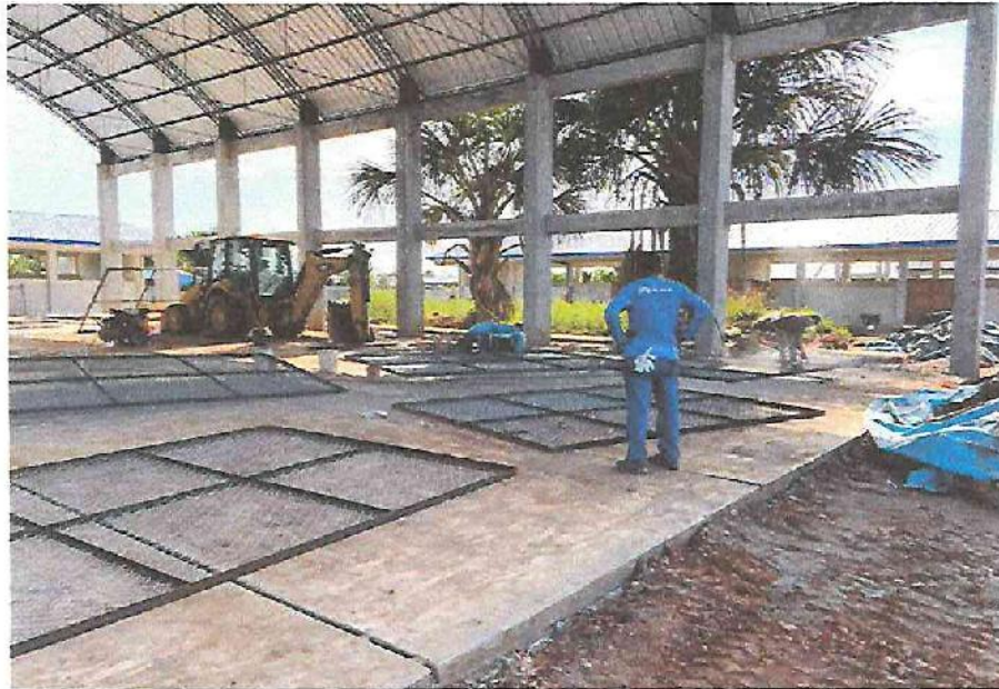
FOTO N°03: Vista de la confección y pintado de rejas de F°G° para campo deportivo en la obra "Mejoramiento y Equipamiento del servicio Educativo N° 62200 Barrio Carabanchel - San Lorenzo, Distrito Barranca, Provincia Datem Del Marañón - Loreto".
