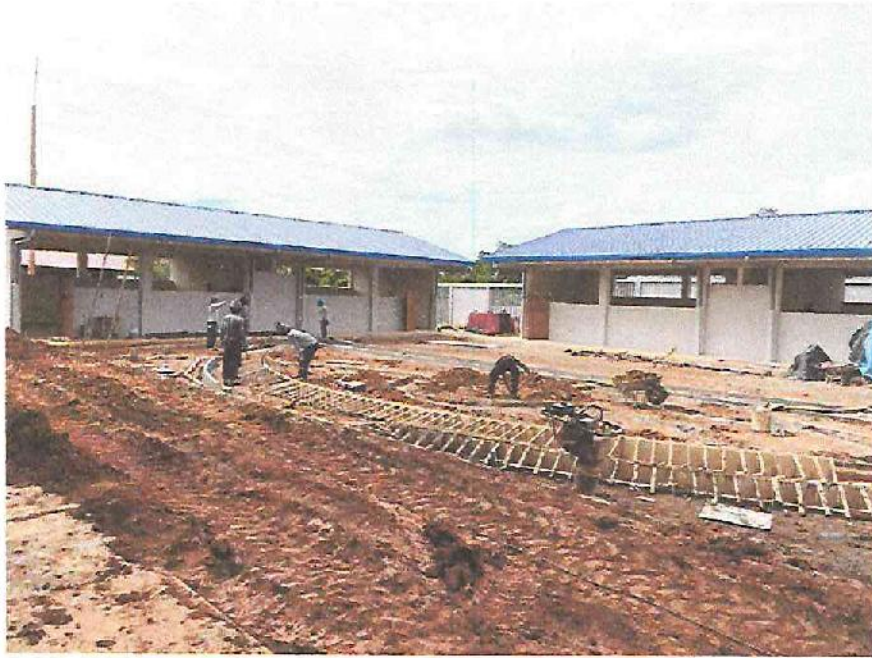
FOTO N°13: Vista del encofrado de cunetas en la zona recreacional para los niños en la obra "Mejoramiento y Equipamiento del servicio Educativo N° 62200 Barrio Carabanchel - San Lorenzo, Distrito Barranca, Provincia Datem Del Marañón - Loreto".
