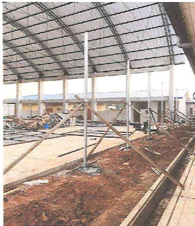
FOTO N°04: Vista colocado columnas F°G° y cimentaciones en polideportivo en obra "Mejoramiento y Equipamiento Servicio Educativo N° 62200 Barrio Carabanchel - San Lorenzo, Distrito Barranca, Provincia Datem Del Marañón - Loreto".
