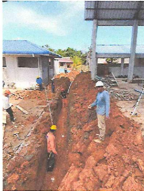
FOTO N°07: Vista del tendido de tubería para desagüe al frontis de polideportivo en la obra "Mejoramiento y Equipamiento del servicio Educativo N° 62200 Barrio Carabanchel - San Lorenzo, Distrito Barranca, Provincia Datem Del Marañón - Loreto".
