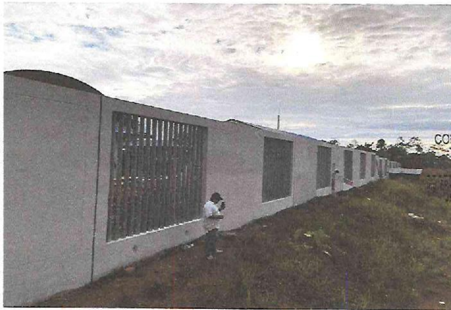
FOTO N°10: Vista del pintado exterior del cerco perimétrico en la obra "Mejoramiento y Equipamiento del servicio Educativo N° 62200 Barrio Carabanchel - San Lorenzo, Distrito Barranca, Provincia Datem Del Marañón - Loreto".
